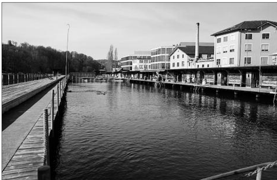
Die Rhybadi muss saniert werden; die Frage ist allerdings, in welchem Masse.
