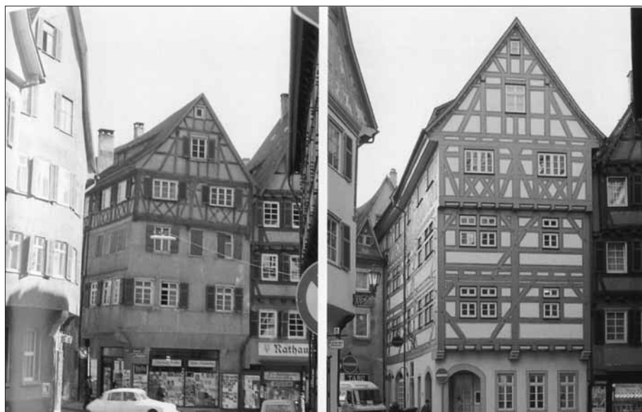
Die beiden Bilder zeigen das Beispiel einer Fachwerksanierung in Esslingen.
