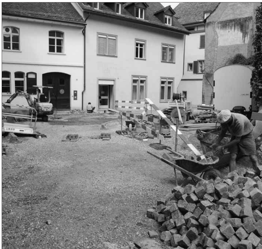
Die Krummgasse erhält neue Leitungen, und deshalb wird jetzt auch die Oberfläche erneuert, die fussgängerfreundlicher werden soll.
