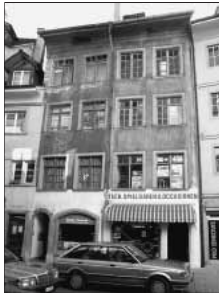
Substanz trotz schlechtem Zustand: Die «Traubenlust»-Häuser an der Vorstadt.
