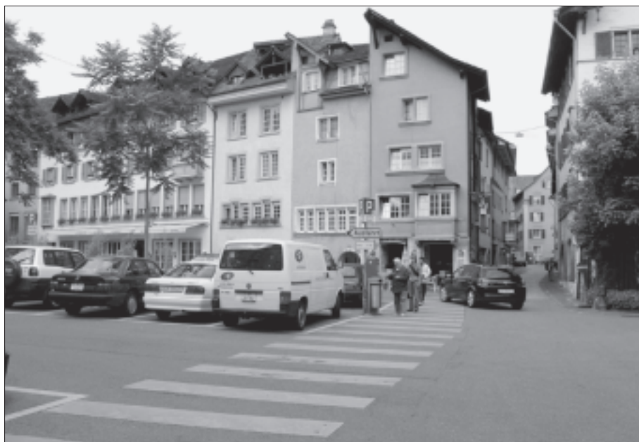
Kirchhofplatz: Lärmprobleme in den frühen Morgenstunden am Wochenende.
