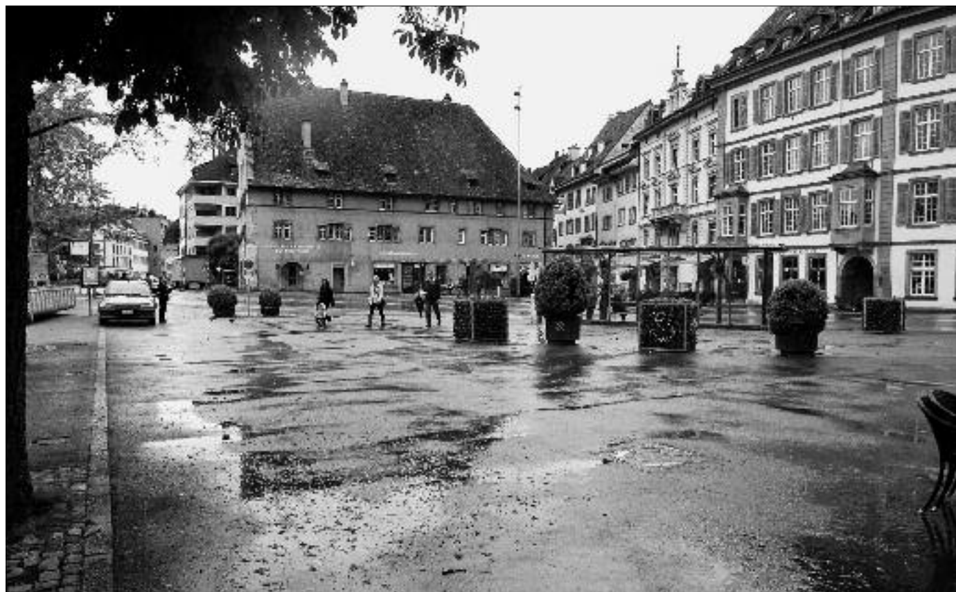
Macht momentan einen eher trostlosen Eindruck, auch wenn die Leitungsgräben jetzt asphaltiert sind: Der Freie Platz.
