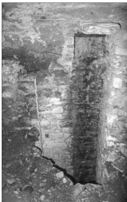
Gemauerte Latrine im Kornhaus auf dem Herrenacker Bild: Kantonsarchäologie Schaffhausen.
