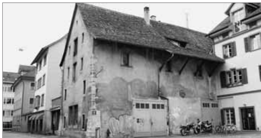
Nach der Sanierung des Konventhauses (am rechten Bildrand) ist die Behausung des Barfüsser-Klosterleiters (Guardian) an der Reihe.
