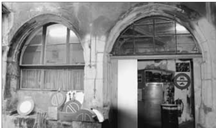
In der Werkstatt der (ausziehenden) Verwaltungspolizei sind die letzten Zeugen des Klosterkreuzgangs erhalten geblieben.
