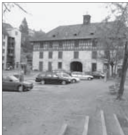
«Kleine Sanierung»: Weniger Asphalt und Autos, mehr Lebensqualität.
