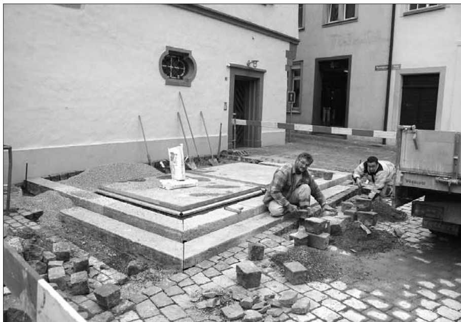
Die neuen Unterflurcontainer (hier am Platz) sind schon bald in Betrieb.
