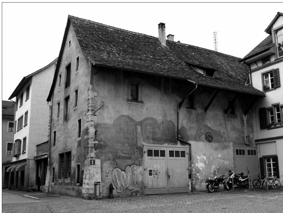
Renovation täte schon lange not: Hier könnte das neue «Stadtbüro» entstehen.
