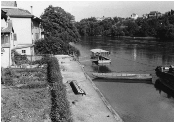
Das städtische Rheinufer vor dem Bau der neuen Strasse, eine Idylle
