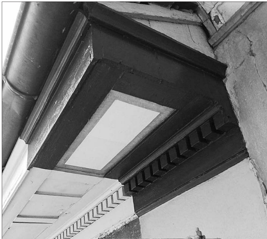
Das Vordach bei der Oberstadt Nr. 10 mit einer Bemusterung zur Wiederherstellung der Fassadenoberfläche.
